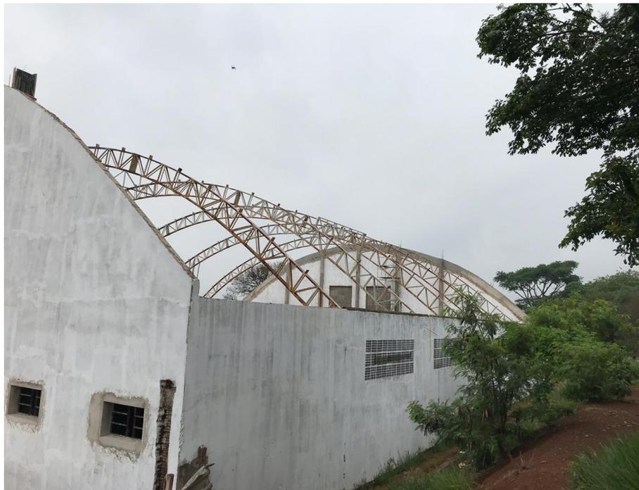
FOTO 01 – DETALHE DAS TRELIÇAS EM ARCO EXISTENTES QUE SERÃO REAPROVEITADAS.
