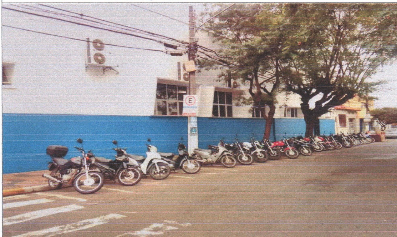
Foto 14 – Fachada externa – vista da Rua Querubino Soeiro
