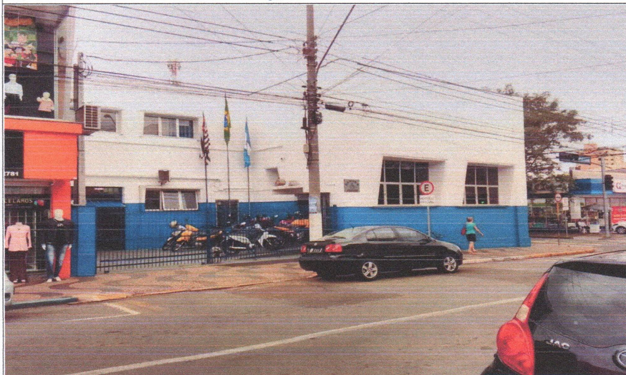
Foto 15 – Fachada externa – vista da Av. 29de Agosto
