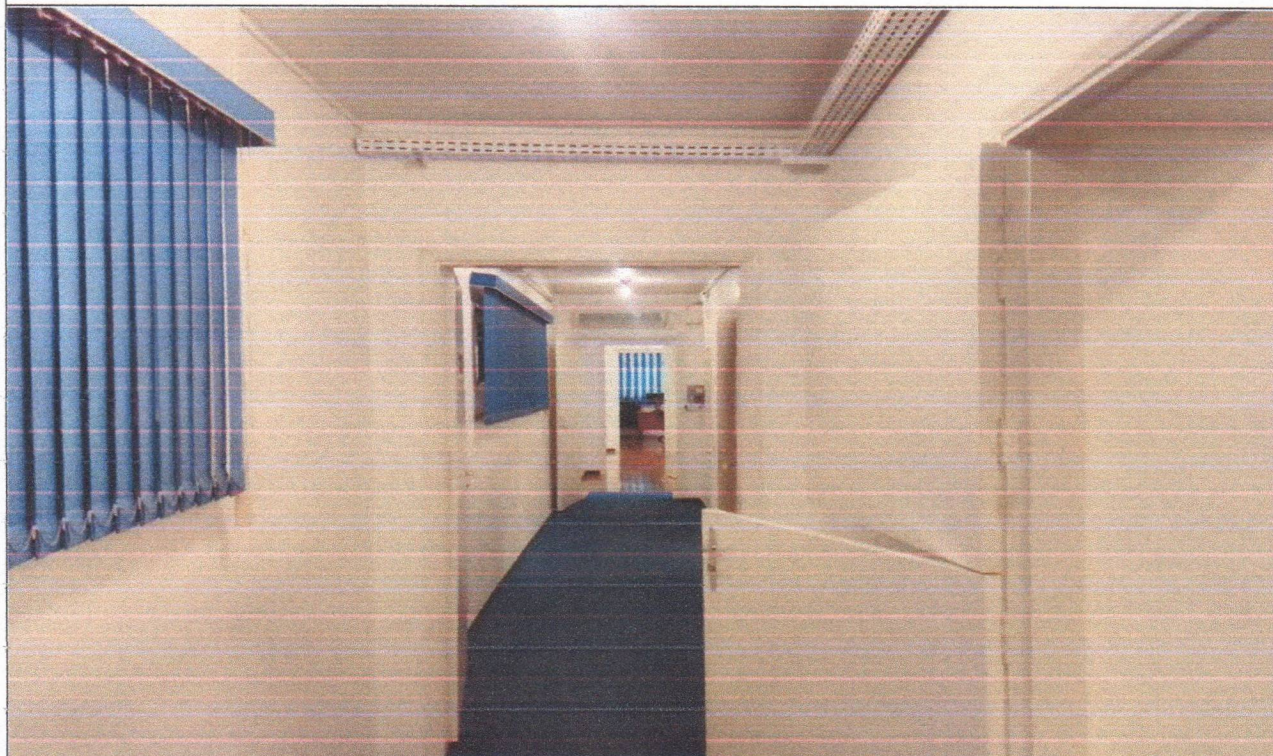
Foto 05 – Corredor interno do Salão
