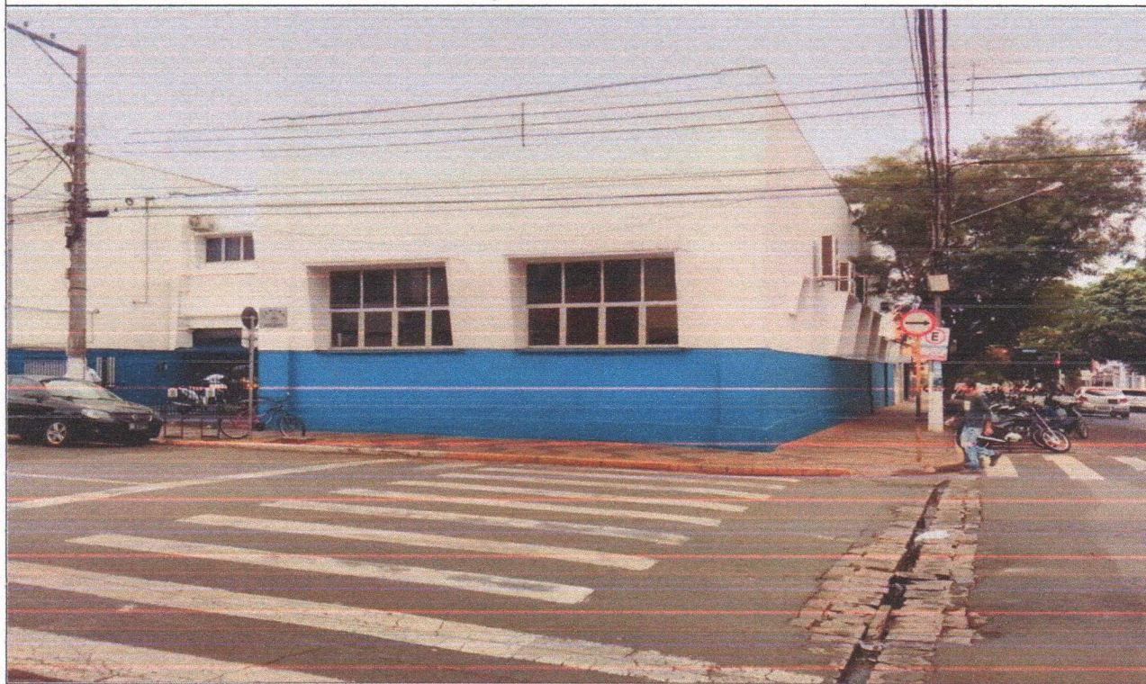
Foto 17 – Fachada externa – vista da Av. 29de Agosto
