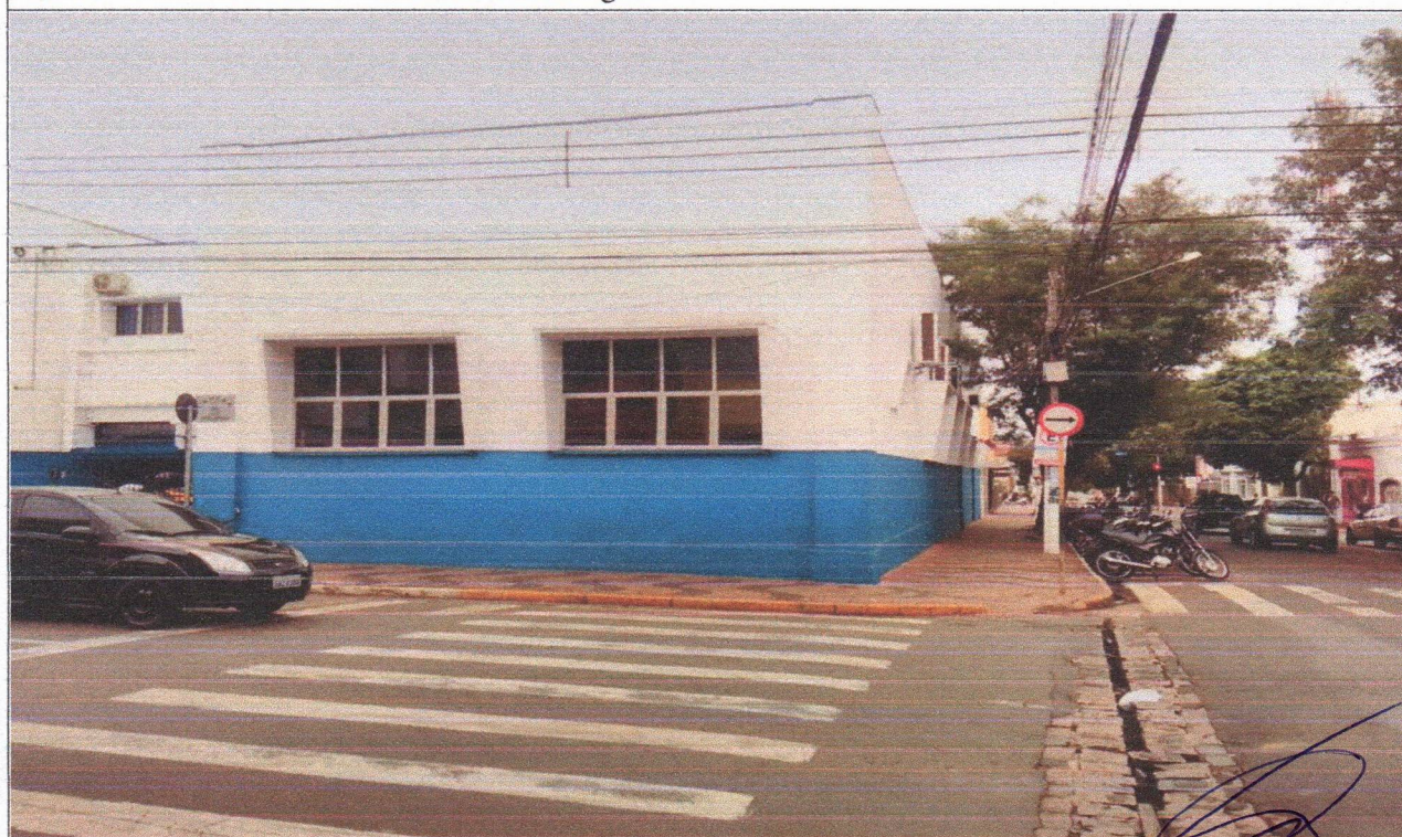
Foto 16 – Fachada externa – vista da Av. 29de Agosto
