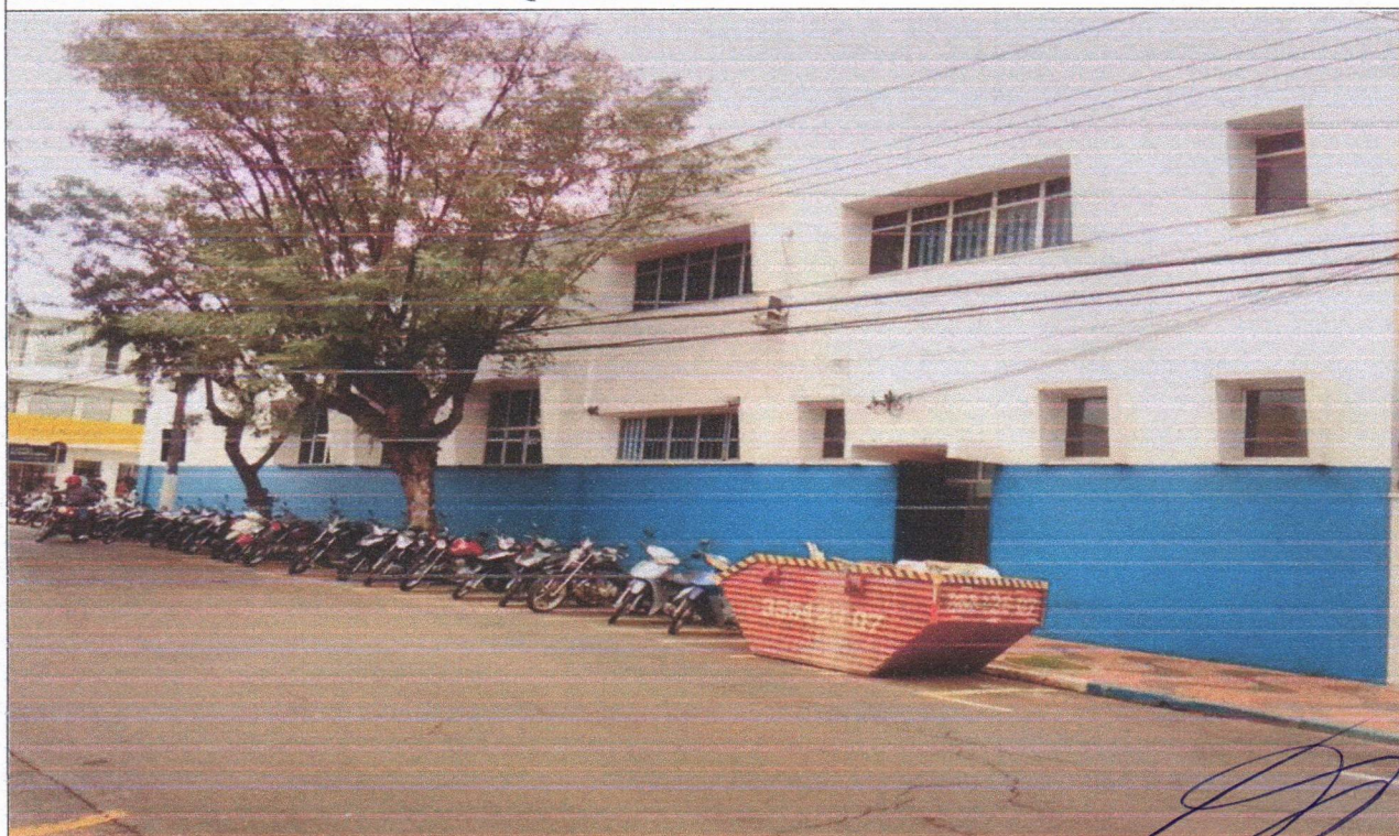
Foto 12 – Fachada externa – vista da Rua Querubino Soeiro
