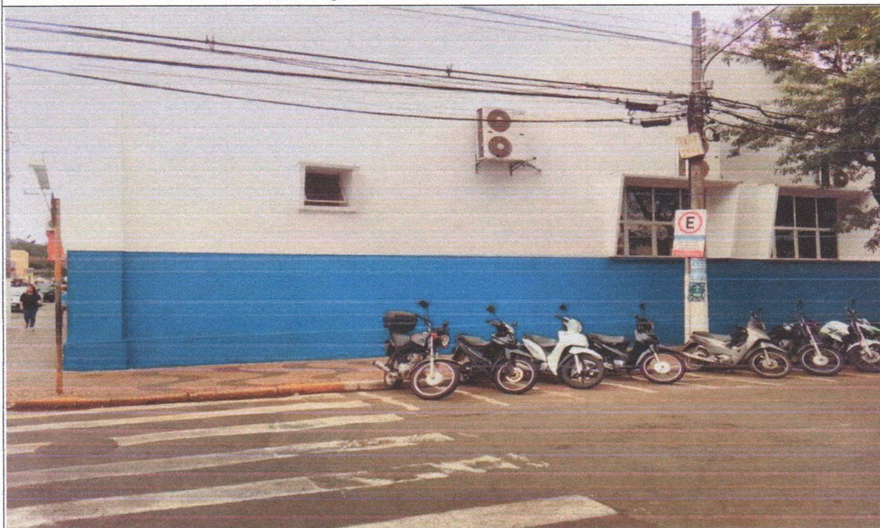
Foto 13 – Fachada externa – vista da Rua Querubino Soeiro
