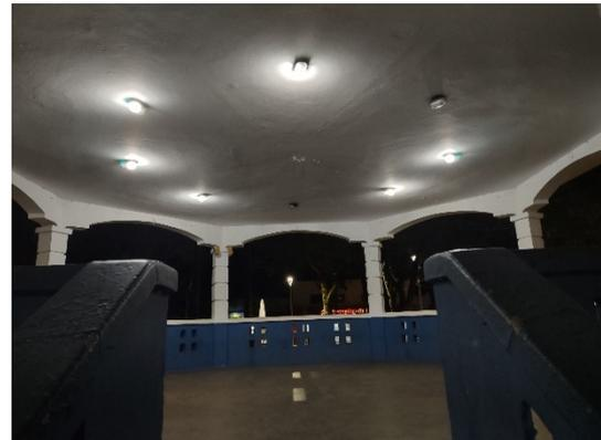
Na parte interna, indica-se a substituição por luminárias LED downlight de sobrepor brancas de 5000K.
