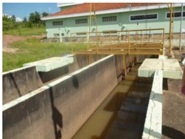
**Foto 4.2 – Canal de Derivação para Poço de Sucção da EEAB1**
