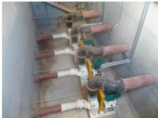
Foto 4.26 – Estação Elevatória de Esgotos Final – Conjuntos Motobomba
