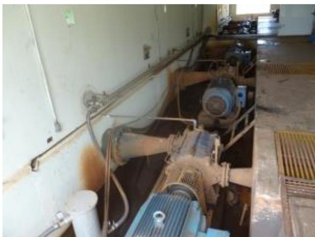
Foto 4.3 – Os Seis Conjuntos-Motobombas Instalados na EEAB1
